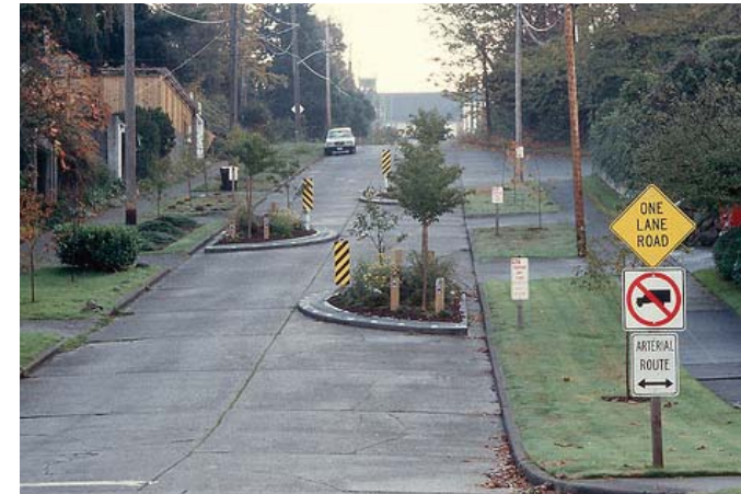
Une chicane réduisant la largeur de la rue à une seule voie de circulation. Source : Andy Hamilton, www.livablestreets.com
