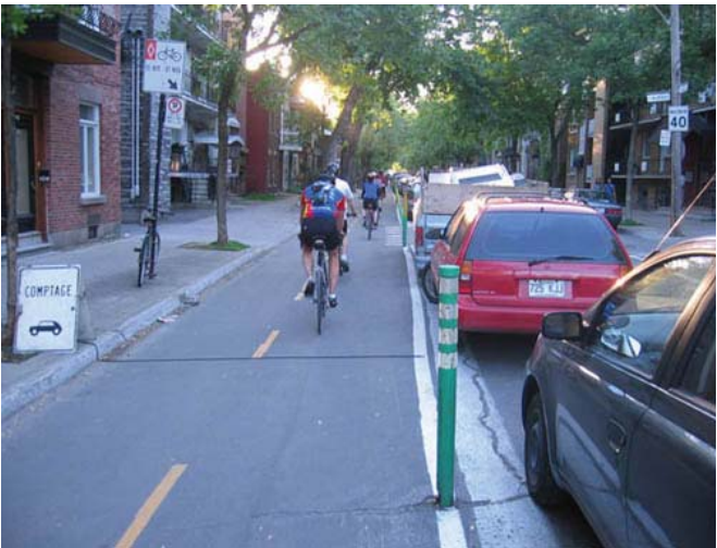
Les bollards indiquent la présence d'une piste cyclable, Montréal. Source : http://www.streetsblog.org
