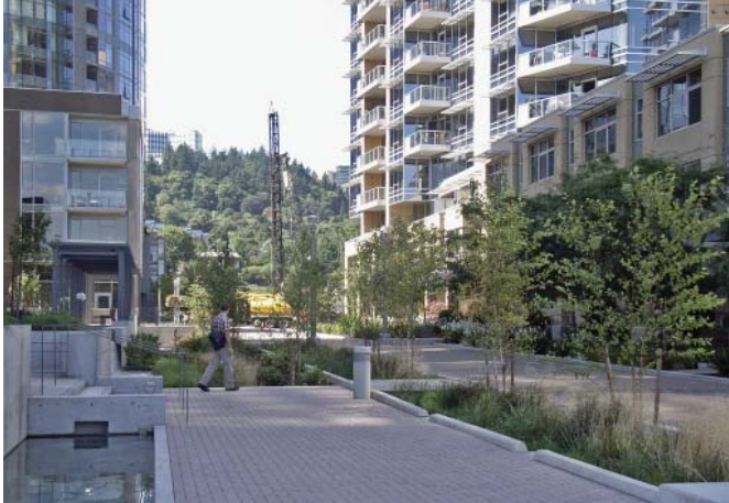
Bassin de rétention des eaux de pluie. Source : www.flickr.com
