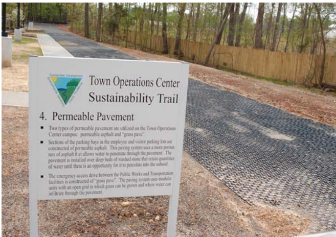
Matériau de revêtement perméable pour la chaussée, Chapel Hill, North Carolina Source : www.flickr.com
