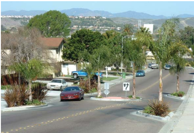
Un aménagement qui combine des avancées de trottoirs et un terre-plein, Californie. Source : Richard Drdul, www.livablestreets.com
